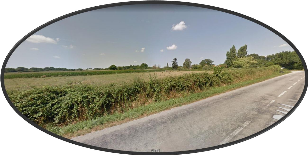
Vue de la voie départementale D114 Sud-Nord
